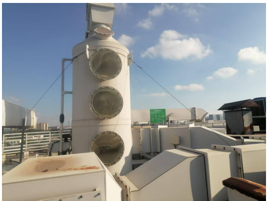
图 4-1 废气处理设施照片
