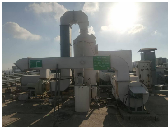
图 4-1 废气处理设施照片
